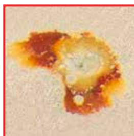
Пример язвенной коррозии
