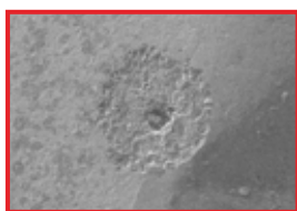
Язвенная коррозия инструмента под действием хлоридов
