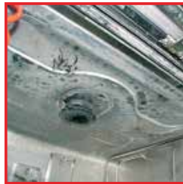
Промывная камера с сильной накипью
