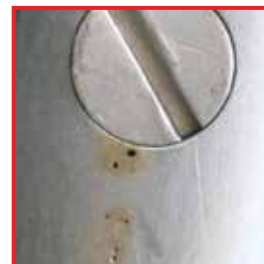
Пример язвенной коррозии
