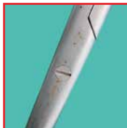
Пример язвенной коррозии
